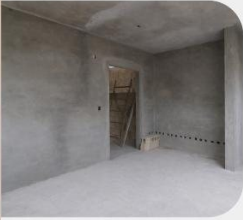
Firme de concreto De 5 centímetros
