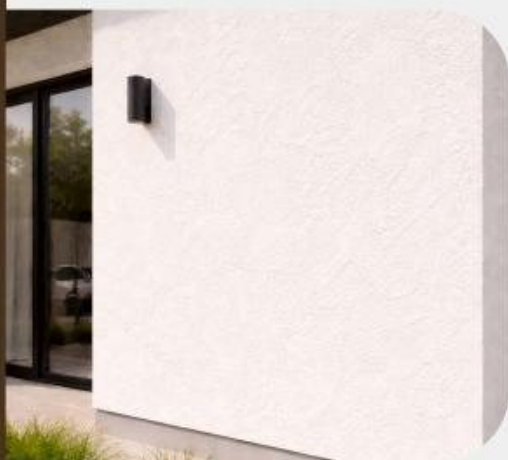
Acabado tipo Emparche Muro exterior
