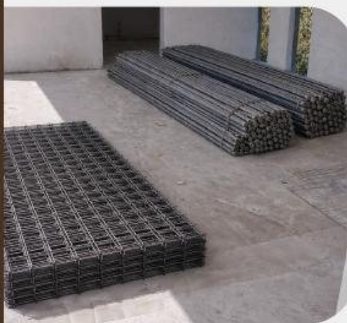
Acero de refuerzo a base de Hermex 15x15x4 / Cabillas de 3/8, 1/2 y 3/4
