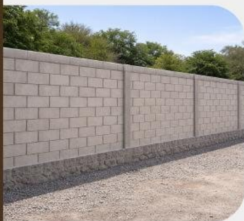
Barras con 10 filas de block Longitud de 30 ml
