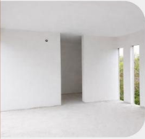
Acabado de yeso Muro interior
