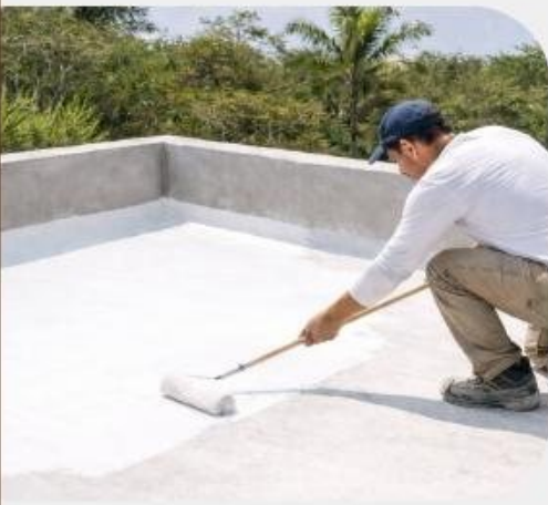
Aplicación de impermeabilizante
